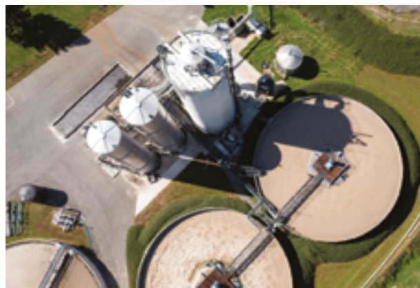
Station d'épuration de Cartonnerie Gondardennes
